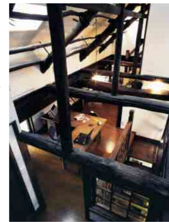
太い梁を活かし見せたことで、旧家リフォームならではの趣を醸し出している。(福島県実例)
