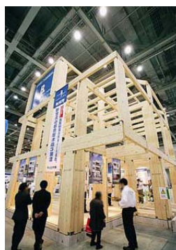
BF構法の実大構造実棟
