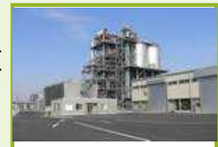
<川崎バイオマス発電>
