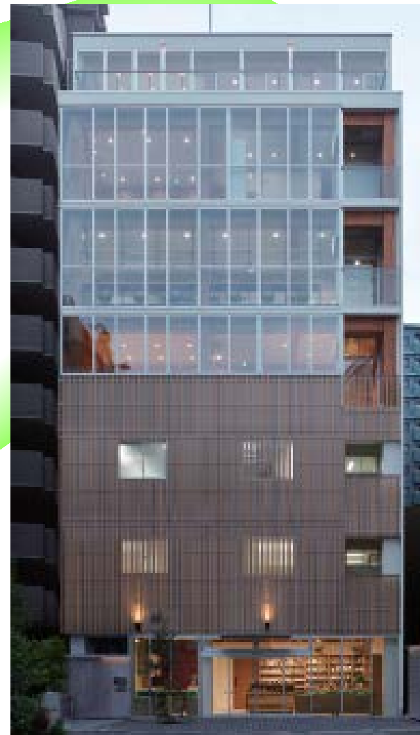
国分寺フレイバーライフ本社ビル 鉄骨造を「木」で耐火被覆した7階建て木質ビル
