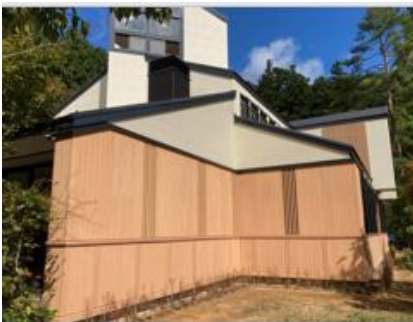
S-100を塗布した建物外壁
