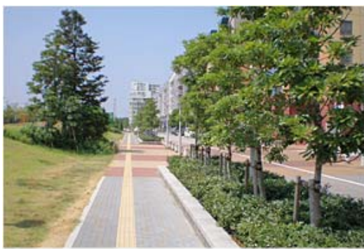
幕張新都心での施工事例
