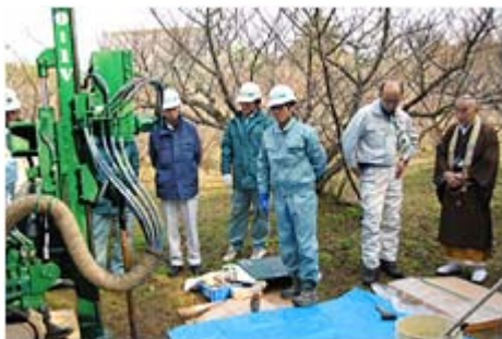
御室桜ボーリング調査
