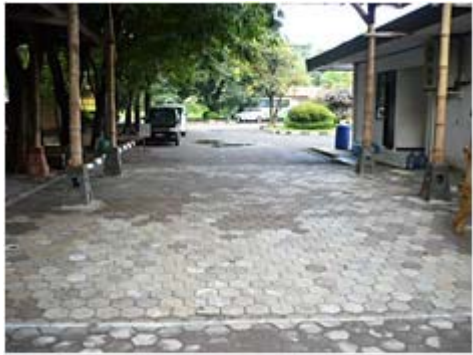
路盤材の施工事例
