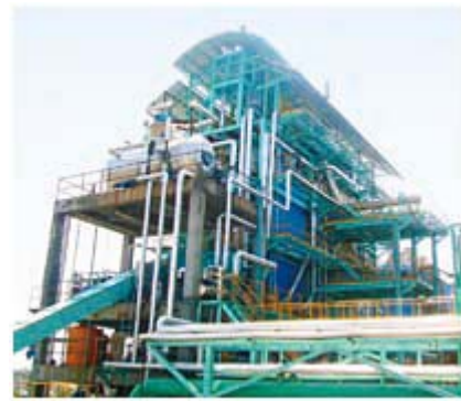
木質バイオマスボイラー
