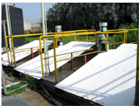
廃水原水プールに屋根を設置し、雨水の混入を防ぐ
