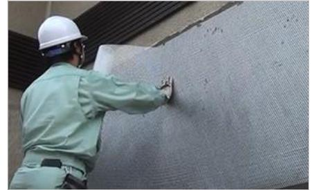
モルタル外壁耐震補強ネットの仮押さえ
