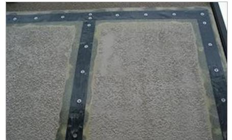
モルタル外壁耐震補強ベースシートの施工後
