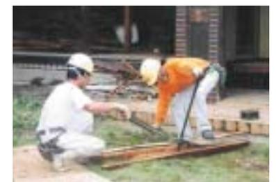
分別解体:重機による解体前の手壊し
