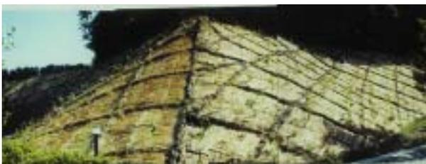
完工後の斜面(この施工例では、斜面をワラで覆い、郷土種の苗木を植栽しています)
