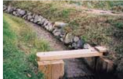
鶴見緑地(大阪市)における水路ぎわでの施工例
