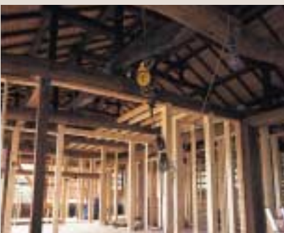
④ ねじれ修正後、新しい柱を追加して、より強固な構造に
