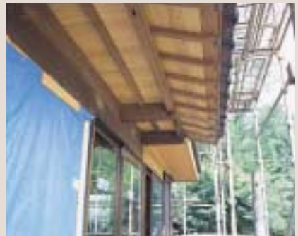
⑥ 屋根や軒下も修復します
