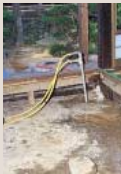
② 地盤の補強
