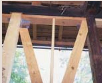
⑤ 筋違いを入れて耐力壁をつくります
