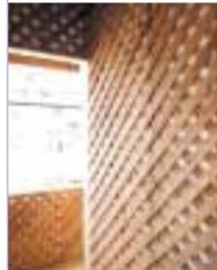
この「きづれパネル」は、幅55mmのスギ材を斜め45度に格子状に接着し、パネル形状にしたもので、合板に比べ強度、通気性などの面で優れています。
