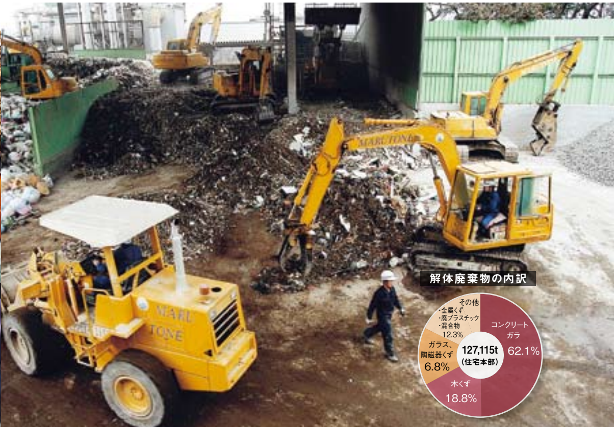
建築廃棄物が集められる中間処理場
