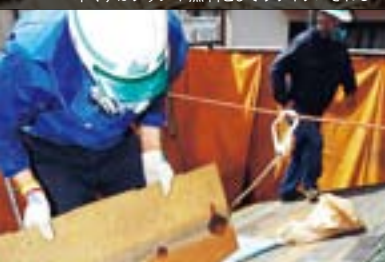
自社基準に則りアスベスト含有建材の解体を行う
