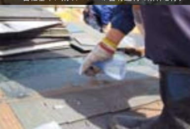
水をかけてアスベストの飛散を防ぐ
