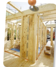
地震エネルギー吸収パネル
