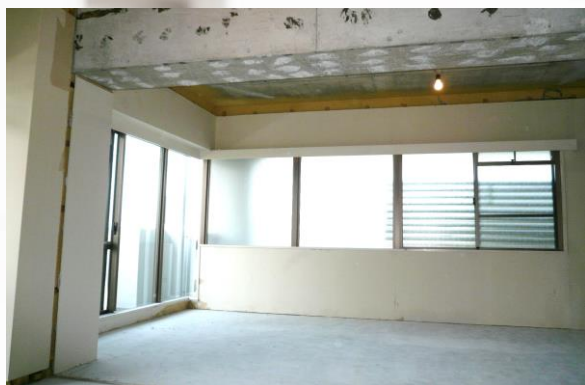
201号室 スケルトン事例
