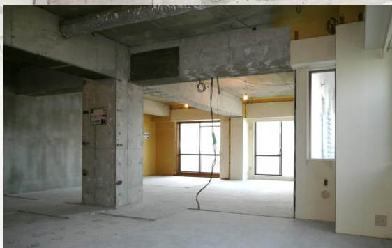
201号室 スケルトン事例
