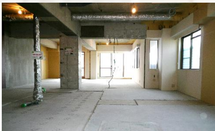
201号室 スケルトン事例
