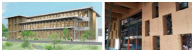
【住友林業 新研究棟@筑波研究所】木造3階建 (準耐火構造) 建築面積: 1,120.27㎡ 延床2,532.67㎡ 木の現して市松状に空洞のある壁は、風や光だけでなく、人の気配も感じられるデザイン。屋上やバルコニー、外壁も緑化の実験場として活用 (今春5月完成予定)。これが夢の『W350計画』に向けた第一歩
