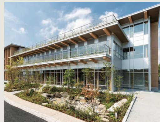
筑波研究所 新研究棟
