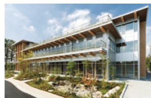
筑波研究所 新研究棟
