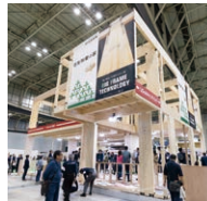
BF構法による構造体
