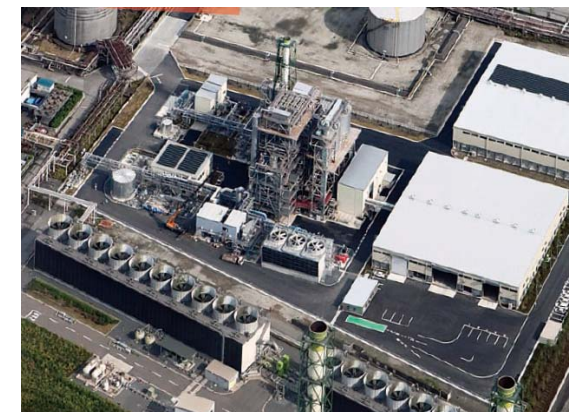
川崎バイオマス発電
