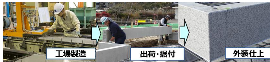
プレキャスト基礎の拡大。立上り部を工場にて製造後、現場に出荷、据付作業。基礎外装も仕上がって出荷されており、精度、意匠性共に完成度が高い
