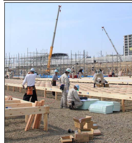
応急住宅の建設現場(宮城県)
