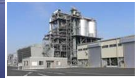
右写真は「川崎バイオマス発電所」
