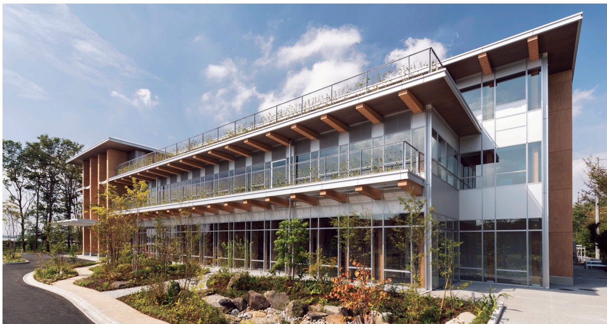
筑波研究所 新研究棟（木造）
