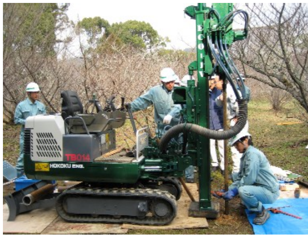
<当日の地盤調査の様子>
