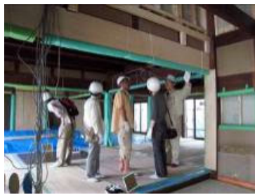
リフォーム工事中のお宅で、耐震技術の解説を聞きながら確認
