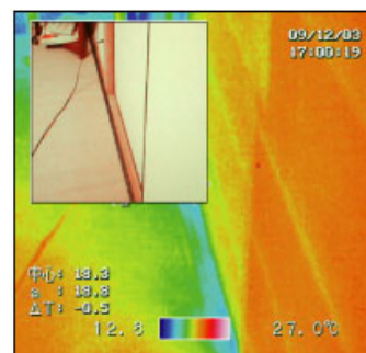
[サーモカメラで漏気や断熱材の欠損部を調査]
