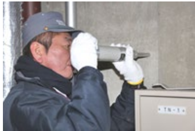
コンクリート強度調査の様子
