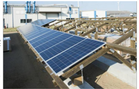
環境にも配慮した木製架台を採用(施工中)
