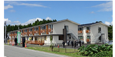
<仮設宿泊施設外観>
