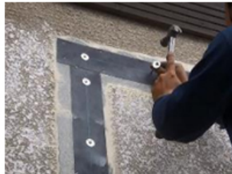
写真左) ベースシートの接着と座金付釘の打込み 写真右) 補強面にネットシートを施工
