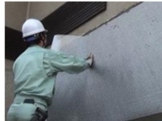
写真左) ベースシートの接着と座金付釘の打込み 写真右) 補強面にネットシートを施工
