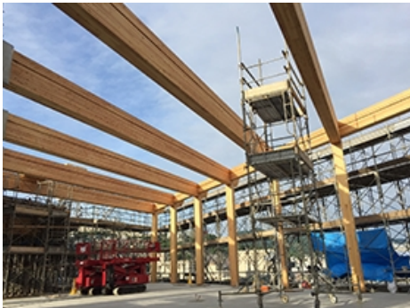
8階展望室建方工事状況
