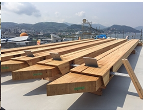
現場搬入状況
