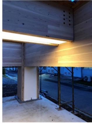
②照明を施工した梁
