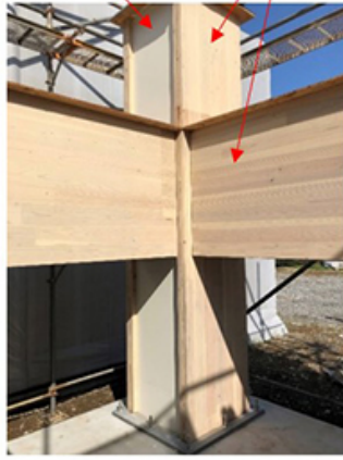
① CLTと化粧ボード仕上げの柱 (化粧ボード部分が面落ち)
