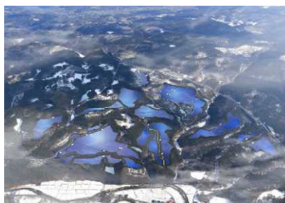
軽米西ソーラー(48MW 建設中)
