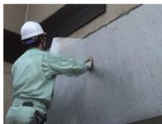
写真左) ベースシートの接着と座金付釘の打込み 写真右) 補強面にネットシートを施工
