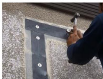
写真左) ベースシートの接着と座金付釘の打込み 写真右) 補強面にネットシートを施工
