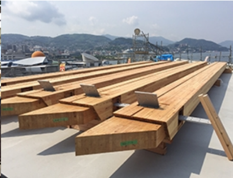
現場搬入状況
