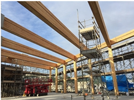
8階展望室建方工事状況
