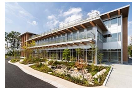
新研究棟は木造3階建て延床面積2,532.67㎡で、梁、柱及び壁は全館避難安全検証法\*1の大臣認定及び燃えしろ設計による木の現し(あらわし)\*2にしています。屋上面にソーラーパネルを設置し、木質ペレット焚吸収冷温水機の導入でCO2排出量を大幅に削減。屋上やバルコニー、外壁も緑化の実験場所として活用することで非住宅木造建築物の緑化技術も研究開発するほか、オフィス空間で知的生産性を向上させる緑のレイアウトを検証します。
