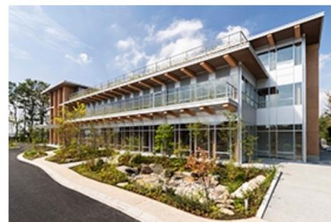
新研究棟の壁柱は縦横1,200mm、厚さ390mm(燃えしろ部含む)のLVL(単板積層材)のブロックを縦方向に市松状に積み上げ、その中に鋼棒を貫き水平力に抵抗するポストテンション技術\*3を用いたオリジナル構造を採用。ゼロエネルギービルディング(ZEB)の実現も視野に入れ省エネや再生可能エネルギー利用を取り入れています。
