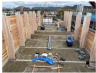
倉庫棟CLT壁柱建て方状況
