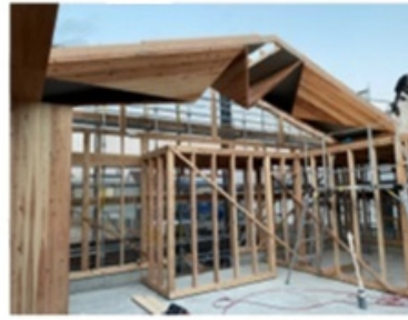
事務所棟CLTトラス建て方状況(2)
