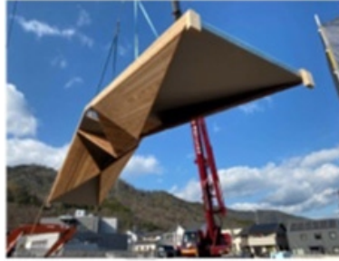
事務所棟CLTトラス建て方状況(1)
