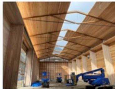
倉庫棟SSP建て方状況
