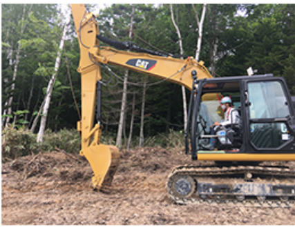
テザーの設置姿勢 Caterpillar社製の油圧ショベル312Fがベース。 折り畳みタワーを立てた状態。
