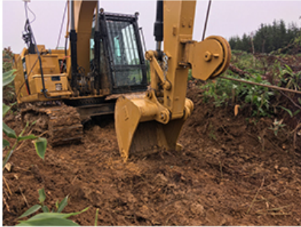
バケットを出につきさして設置。
