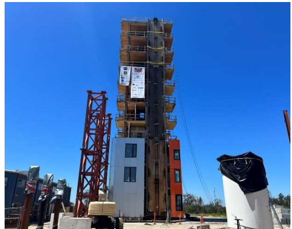
10階建て木造ビル試験体全景
