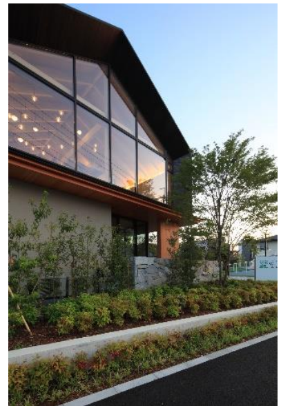
<妻壁を大開口サッシとし外部からも木組みの美しさを感じられる設計>
