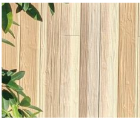
木調アクセント外壁
