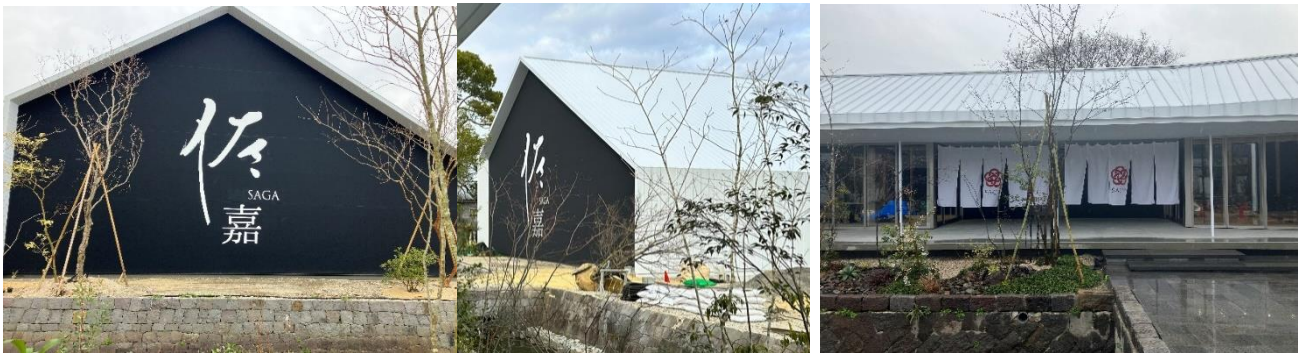
冷蔵倉庫棟 外観(左:黒の妻壁、右:白の外壁)
