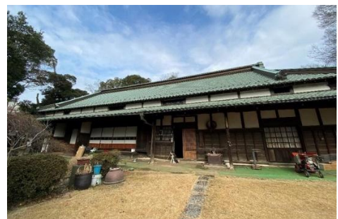
▲池谷家住宅主屋(改修前)
