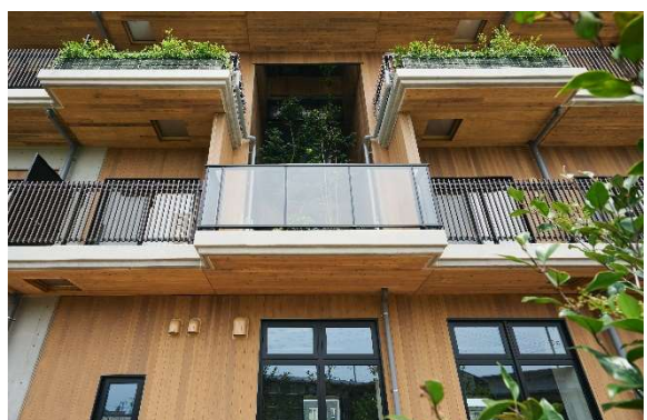
仕上げ材にCLTを使用した軒裏(南側)
