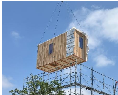
ユニット設置中写真
