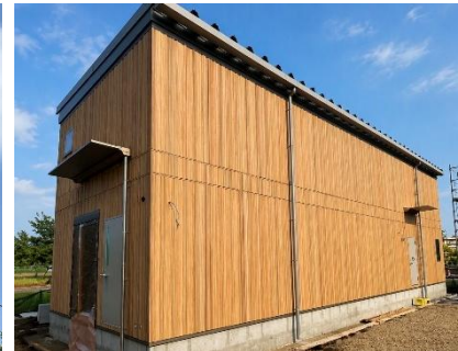
バックオフィス棟完成写真(外観)
