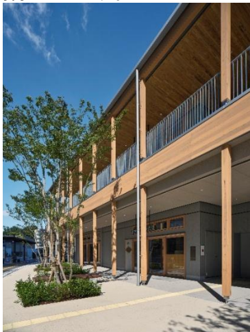
「SUSTIMBER」仕様の建物の正面ファサードの木柱
