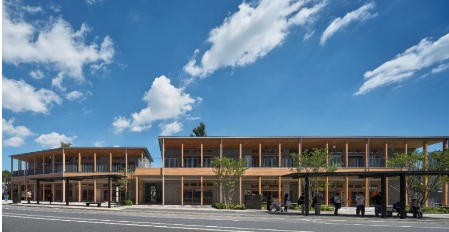
純木造2階建て低層商業施設「HANARE 南」
