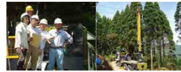
車載型タワーヤード作業風景
