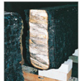
構造材の表面に形成された炭化層
