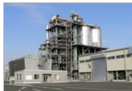
川崎バイオマス発電所の設備
