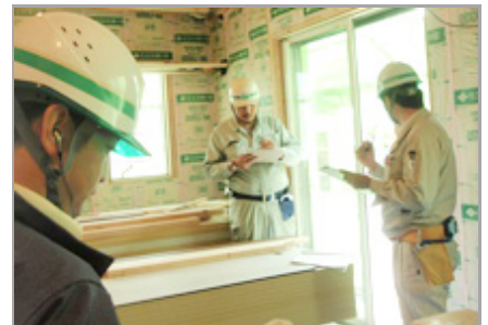
建築現場の安全確認
