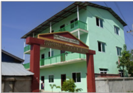
ミンガラドーン地区に完成した 寺子屋
