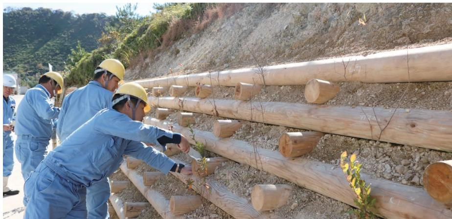
風倒木の丸太を利用した土留め。また丸太の間に植樹することで土固めとなる
